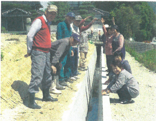
待望の水路工事
